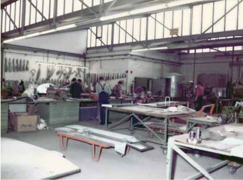
Die Schlosserei in der 1968 neugebauten Shedhalle mit der charakteristischen Dachform.
