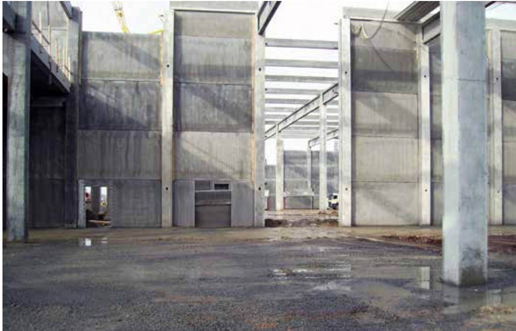
Die Dimensionen lassen sich nur erahnen: Links ein Foto des bisher größten Auftrags für den Kühlraumbau in der Firmengeschichte, bei dem rund 60 000 Quadratmeter Paneele verbaut wurden, rechts der Blick in die Baustelle des mit 8500 Quadratmetern flächenmäßig bisher größten Tiefkühlraumes, den Kramer realisiert hat.
