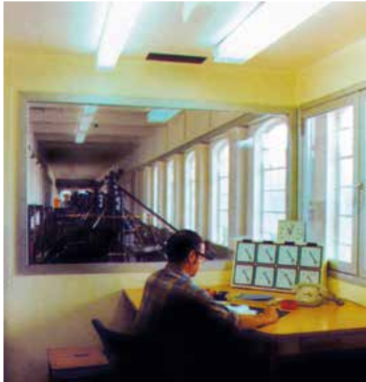
Schallschutz – ein weiteres Segment, in dem Kramer in den 1970er und 1980er Jahren vielfältige Lösungen für die Kunden realisierte. Die Fotos zeigen einen schallgedämmten Arbeitsraum in einem Flusskraftwerk (links) sowie eine schalldämmende Kabine.
