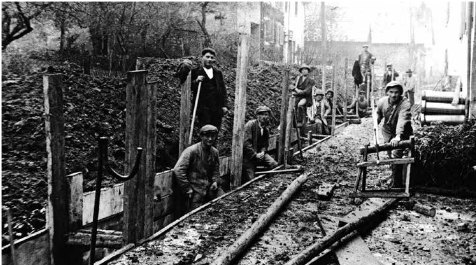
Die Schlossgasse in Grenzach erhielt 1928 eine Kanalisation. Das Foto vermittelt einen guten Eindruck der Arbeitsverhältnisse auf der Baustelle. Im darauffolgenden Jahr gründete Fritz Kramer sein Unternehmen.
