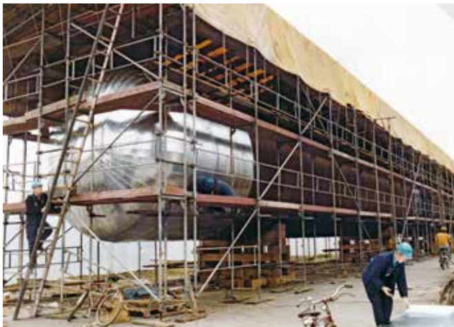
Größe spielte keine Rolle: Beispiel der Dämmung von drei erdverlegten Lagerbehältern mit Korkdämmstoff in Heißbitumen.
