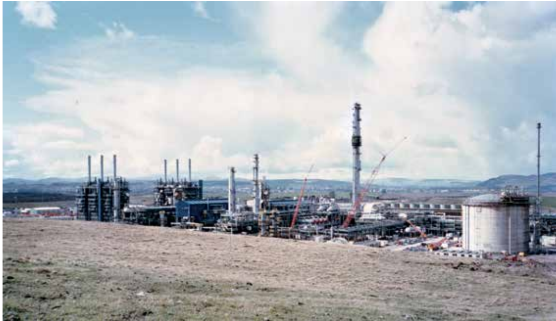
Die Erdgasraffinerie im schottischen Cowdenbeath, Fife, entsteht.
