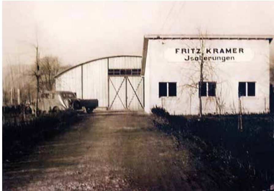
1936: Firmengebäude und Lagerhalle der Firma Fritz Kramer Isolierungen in Rheinfelden im Bau und im fertiggestellten Zustand.
