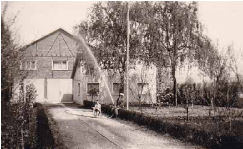
Fritz Kramer 1938 vor der neuen zweistöckigen Lager- und Montagehalle.
