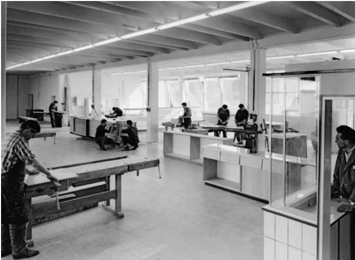
1963: Blick in die neuen Werkstätten.
